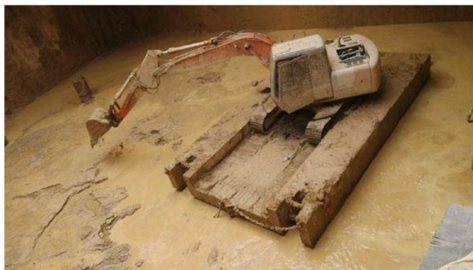
深圳平安金融中心南塔基坑底软化图片二
